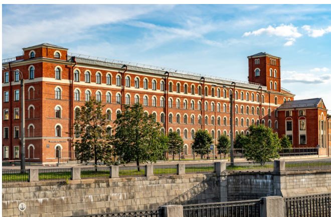
Наб. Обводного канала, д. 60
